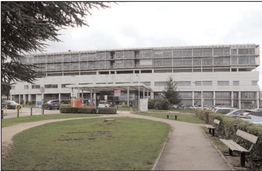
Alors que l'institut Louis-Mathieu et son voisin le bâtiment Philippe-Canton, de construction assez récente, resteront en place...
