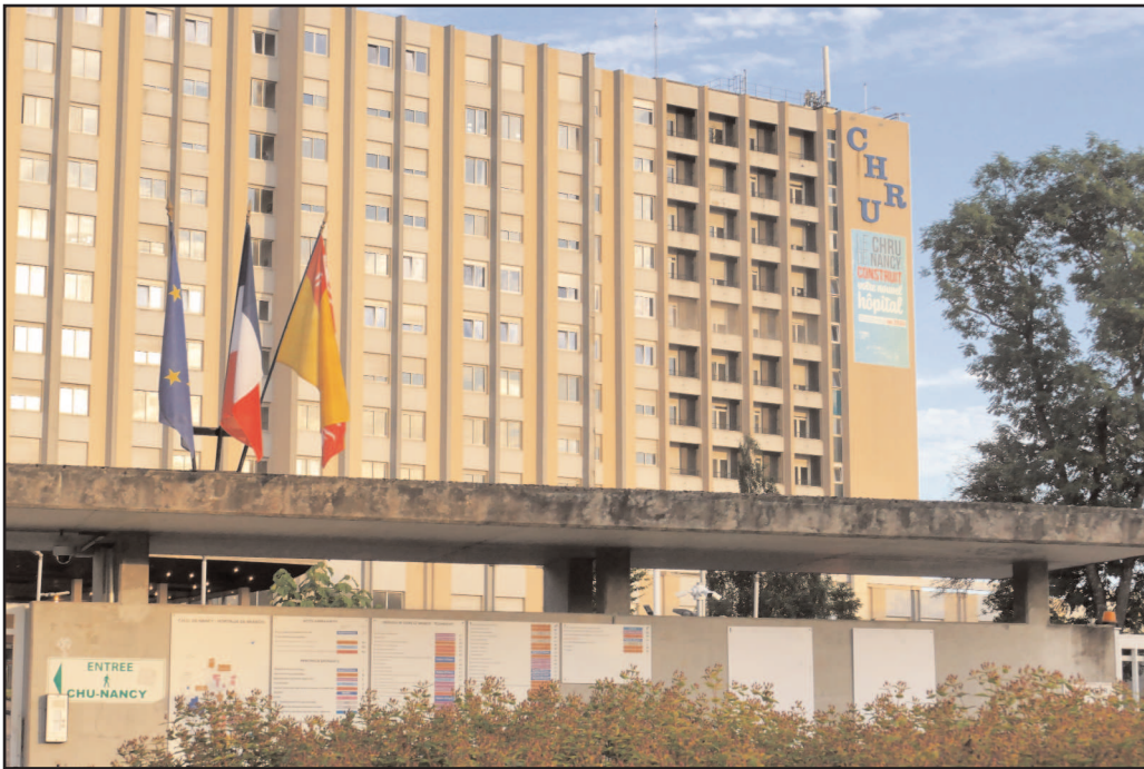
Le projet de Nouvel Hôpital de Nancy prévoit la démolition de la « grande barre » de Brabois après la fin des travaux de construction des nouveaux bâtiments.
