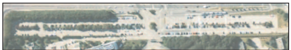
Un millier de places de stationnement gratuites avant la construction des parkings-silos.
