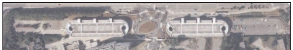
Du béton en plus et 1200 places payantes actuellement.
